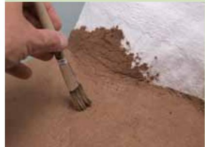
Die glatte Oberfläche erhält mit einem groben Pinsel Struktur.
